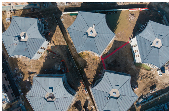
Logements collectifs - Sergisson Bates
