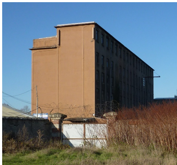
Vue du Moulin depuis la Pointe Nord du site détruit en 2024
