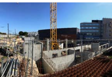
POLYCLINIQUE DU PARC (travaux d'extension) Caen, Calvados
