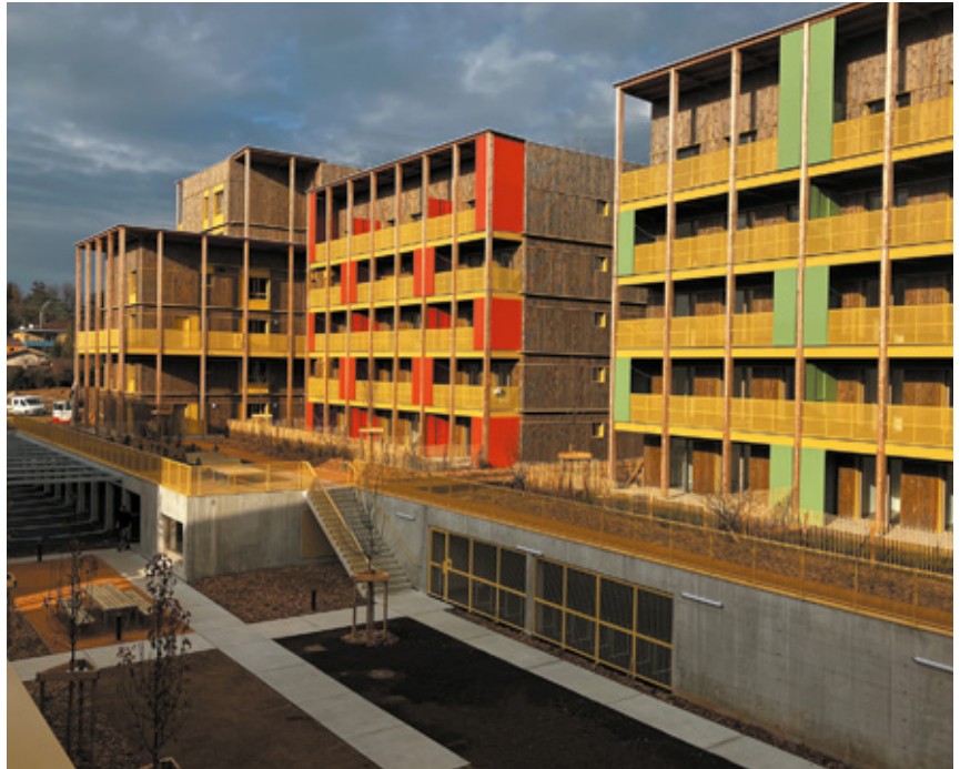
Origine, Trévoux (69). Un ensemble de 84 logements et une chambre d'hôtes pensé pour répondre à un climat plus chaud grâce notamment à l'utilisation du bois, qui participe au rafraîchissement des appartements en été et conserve la chaleur l'hiver.
