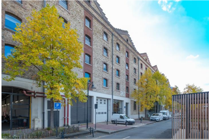
Data Center 260, Parc des Portes de Paris (Seine-Saint-Denis)
