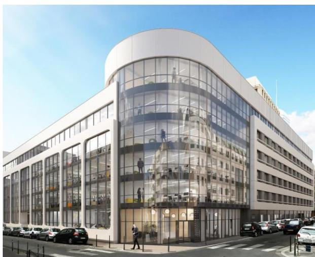
Ces bâtiments, entièrement réhabilités avec une extension et une surélévation, développent 6 960 m<sup>2</sup> de bureaux, et font l'objet d'une double certification : NF HQE Bâtiment tertiaire et Breeam Very Good.
