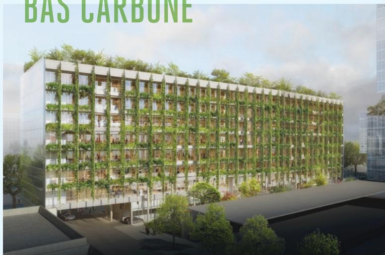
**La tour Thémis à Paris est exemplaire en matière de développement durable.** Structure mixte béton et bois (labellisé FSC® ou PEFC), espaces végétalisés, recours à la géothermie, optimisation de l'éclairage naturel et garantie de résultat énergétique pendant 3 ans : ce programme bénéficie d'une double certification HQE Exceptionnel et BREEAM Excellent, couplée à trois labels exigeants (effinergie+, Biosourcé et BBCA-Bâtiment Bas Carbone).
