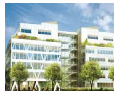
Immeuble Le Monet 22 000 m 2 en construction Pré-commercialisé à SNCF Architecte : Ch. Devillers
