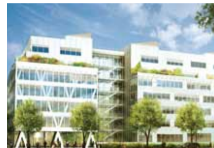
Projet Le Monet - Architecte : C. Devillers
