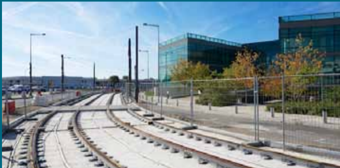
Chantier du tramway T7 - Parc Silic Orly-Rungis
