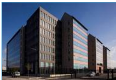
Bâtiment 521, Aubervilliers (19 000 m 2 )
