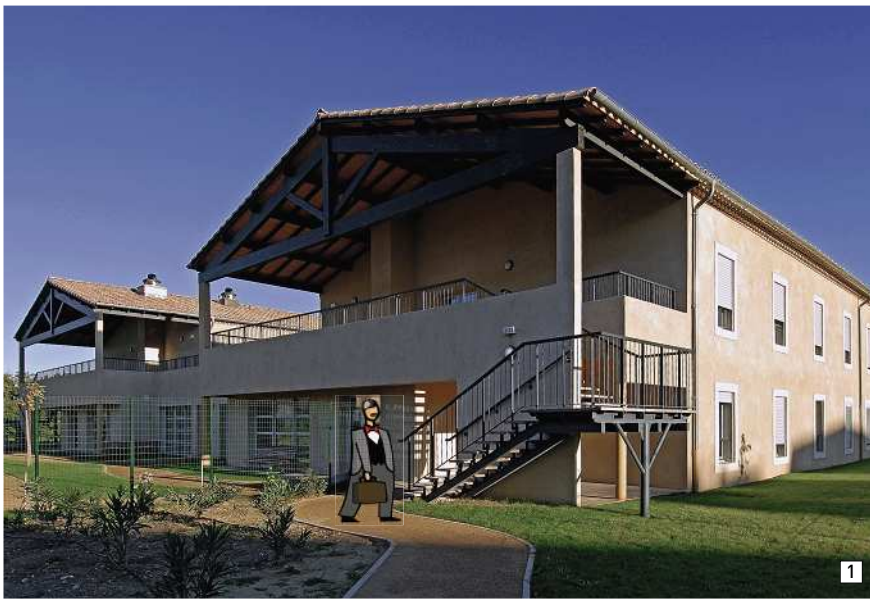
1. Établissement d'hébergement pour personnes âgées dépendantes Caunes-Minervois (11)
