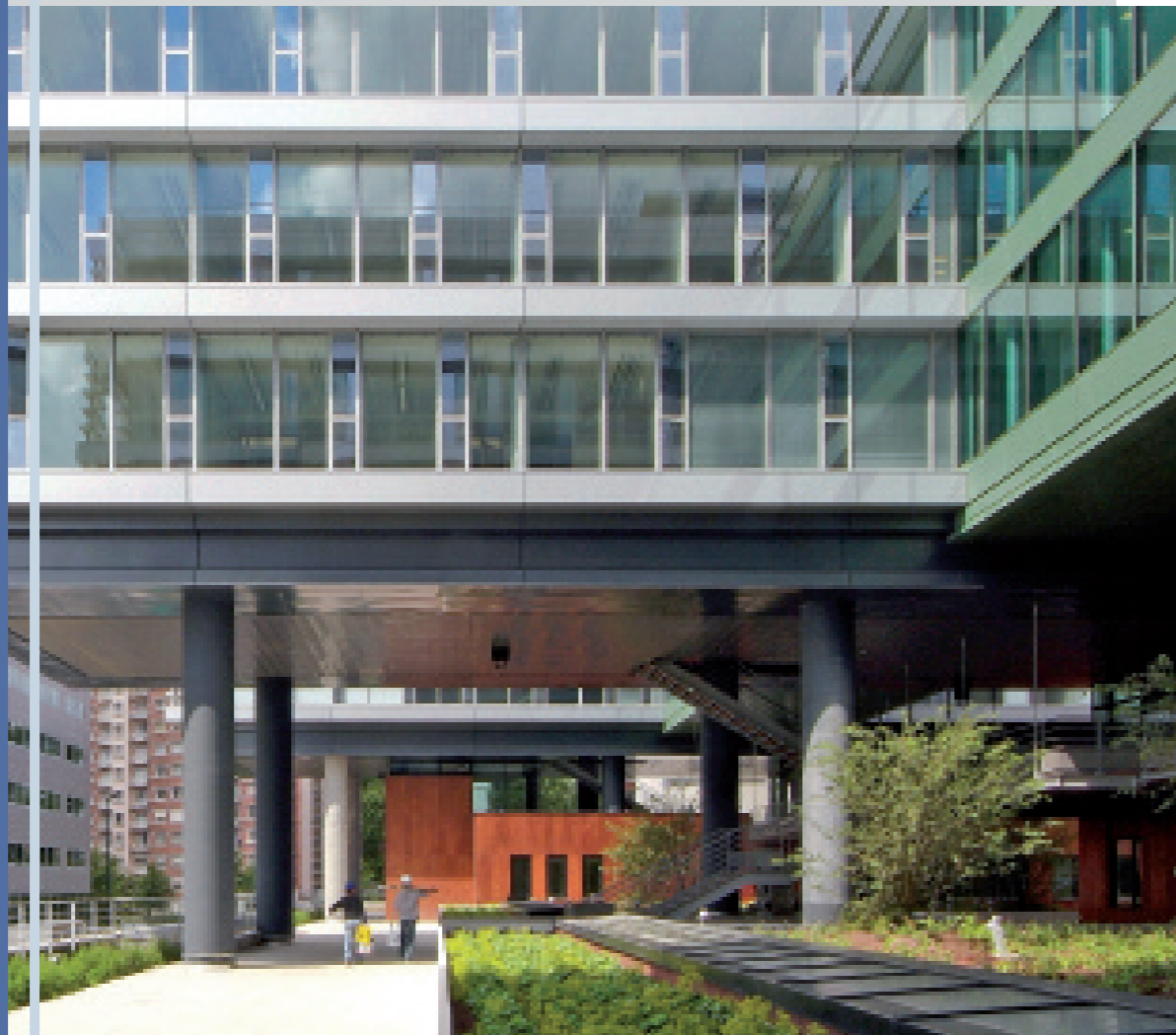
Siège de la Région Nord-Pas-de-Calais Lille (59) 51 000 m 2 shon Icade G3A : mandataire Architectes : Delemazure - Neveux - Trace - Wilmotte Maître d'ouvrage : Région Nord-Pas-de-Calais
