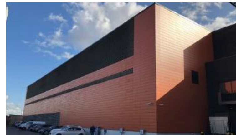
EQUINIX (Parc des Portes de Paris)
