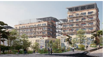
LA PLATEFORME, MARSEILLE Bouches-du-Rhône
